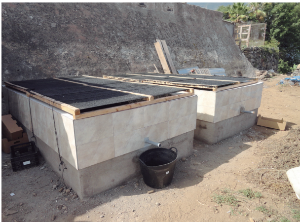
Construcción de un lecho en Los Realejos Finca Los Almendros
