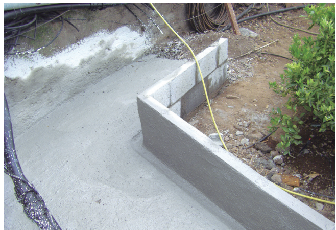
Construcción de un lecho en Guía de Isora Biofinca Las Dulces
